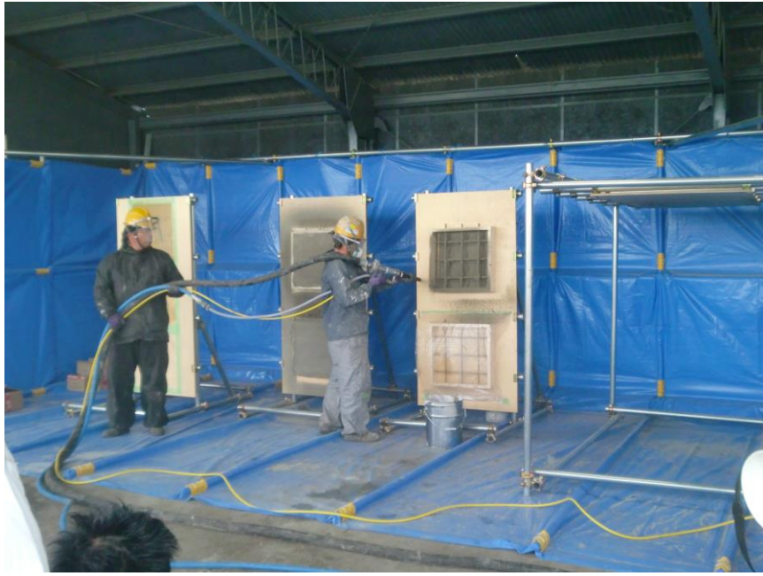
写真-2 施工デモ状況
