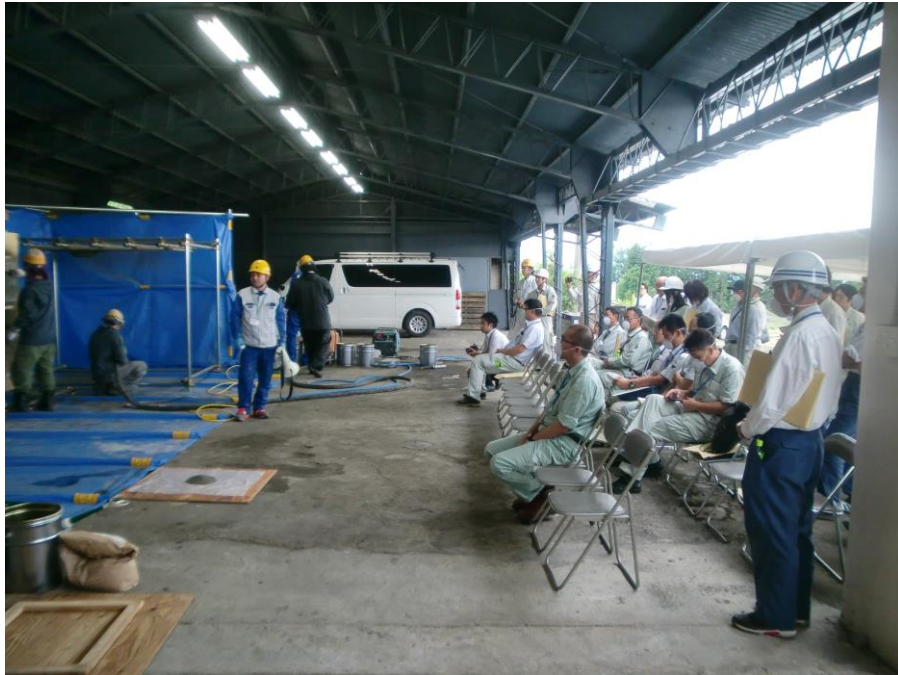
写真-3 施工デモ状況
